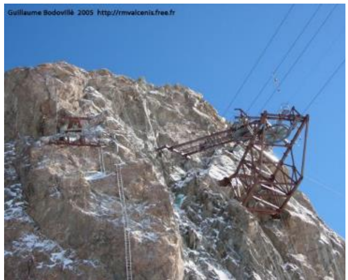
Photo 93 Poulie du téléski implantée en falaise
