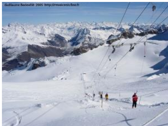
Photo 19 Ligne et pylônes suspendus du TK de la Girose (Crédit : Guillaume Bodovillé)
