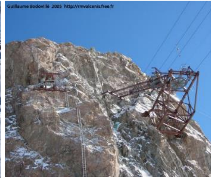
Photo 101 Poulie des téléski des trifides et de la Girose implantée en falaise.
