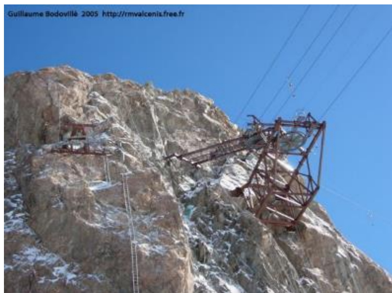
Photo 17 Poulie du téléski implantée en falaise
