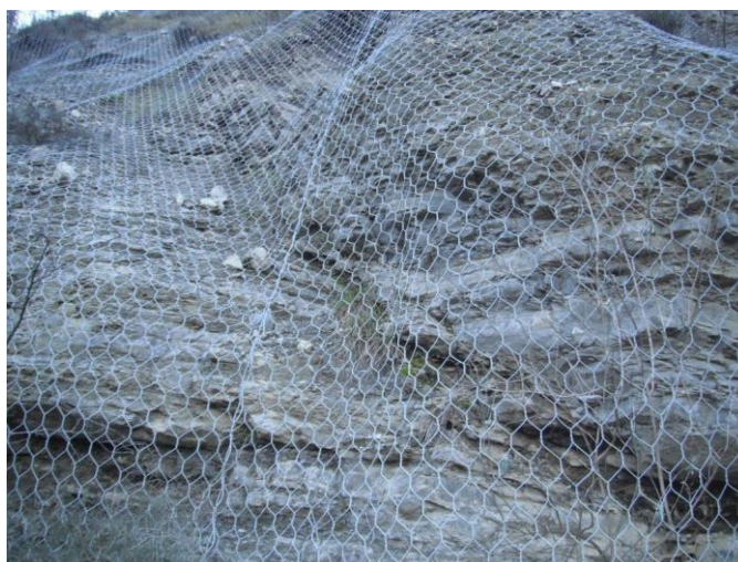
Photo 5 Exemple de grillage de stabilisation plaqué au sol
