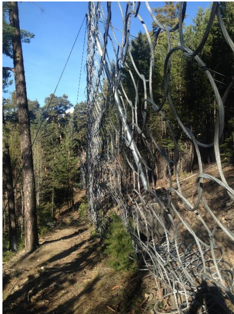
Photo 3 Exemple d'écran pare-bloc qui sera installé en aval de la zone de terrassement.
